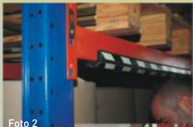
Foto 2 - Proteção e Sinalização de obstáculos em baixa altura existente nas vias de circulação
